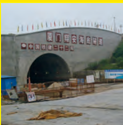
厦门翔安海底隧道监测
