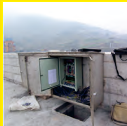
水布垭大坝监测
